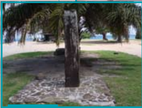
La pierre avant les travaux sur la darse de Papetoai.
