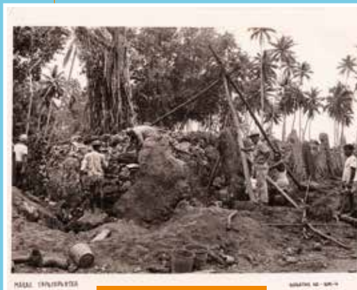
La restauration de Sinoto
