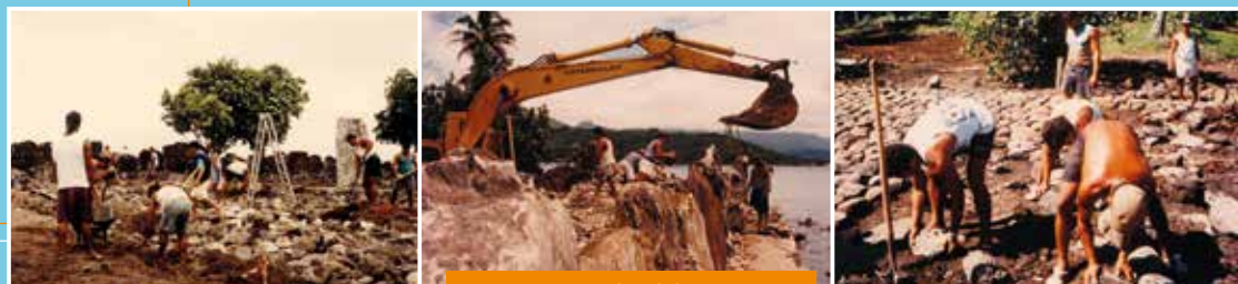
Le marae Hauvirī lors de la restauration
